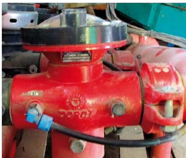
Slika 7. 8: Membranski zaporni ventil (G. Leskošek).
