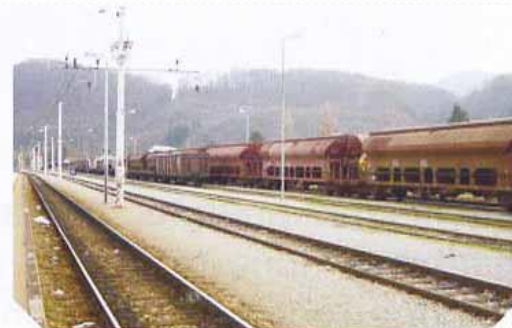
Vlak, tirnice, električni vodniki
